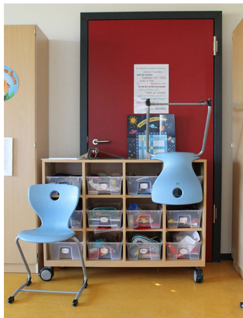
Abb. 2: Versperrter zweiter Rettungsweg
