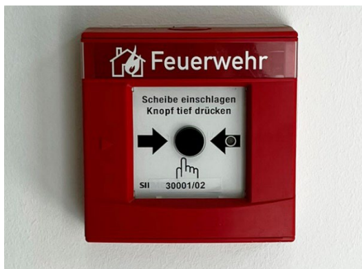
Abb. 13: Handfeuermelder Brandmeldeanlage
